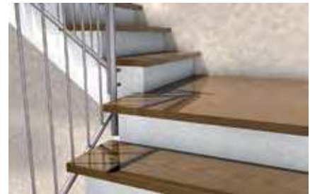
Лестничные ступени на бетонных лестничных балках
