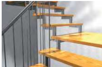
Лестничные ступени на стальных лестничных балках
